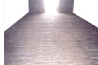
Ducteria cubierta con material aislante
