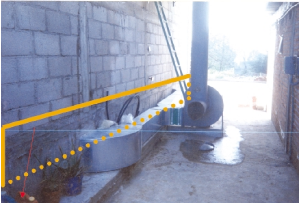
Pleno sobre el piso sin excavación
